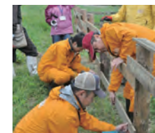
霧多布湿原での木柵の整備
