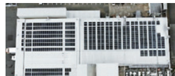
キタカミデリカ屋上に設置した太陽光パネル
