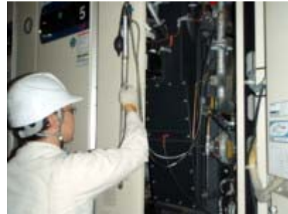
ボイラーの点検
