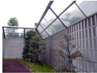
防音壁の設置 (キューピー 中河原工場)
