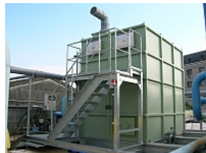
新たに導入した生物脱臭装置 (キューピー挙母工場)
