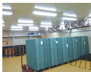
空調設備と照明の更新
