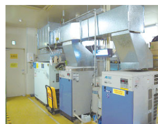
空気圧縮装置の排気ダクト設置
