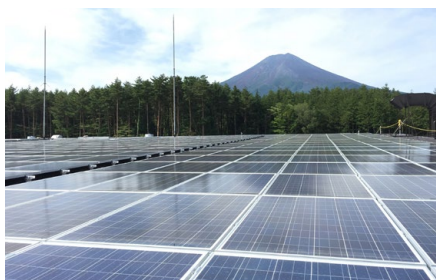
▲ キューピー富士吉田での太陽光パネルの設置
