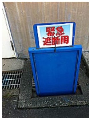
▶ 緊急遮断弁(富士吉田キューピー)
