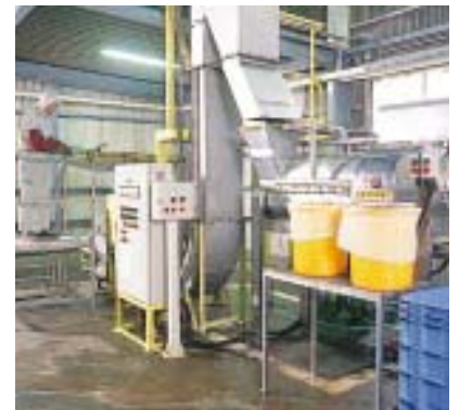
ポリ破碎・洗浄・脱水設備(五霞工場)
