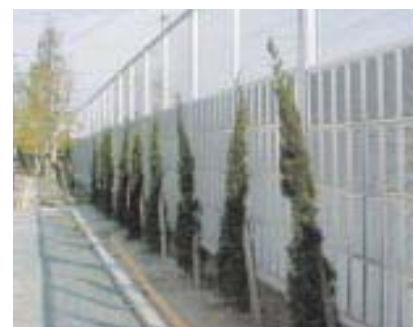
防音壁（鳥栖工場）
