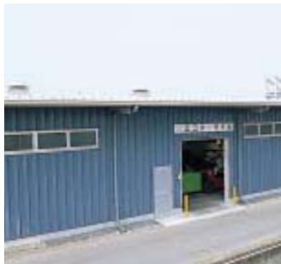
廃棄物一次保管場所(五霞工場)
