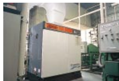
コンプレッサー (仙川工場)
