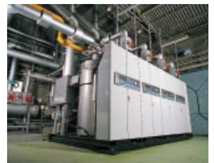
貫流ボイラー（挙母工場）
