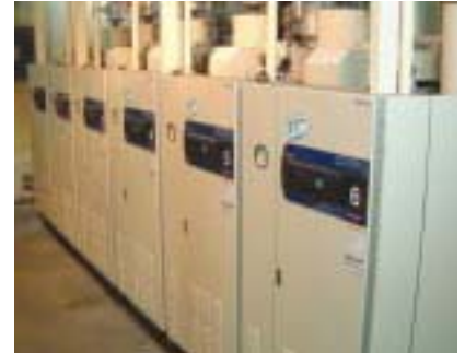
高効率小型ボイラー（中河原工場）
