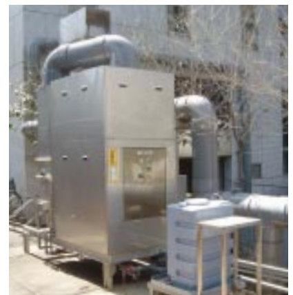
脱臭装置（仙川工場）
