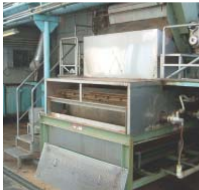
導入した汚泥乾燥機( 挙母工場 )
