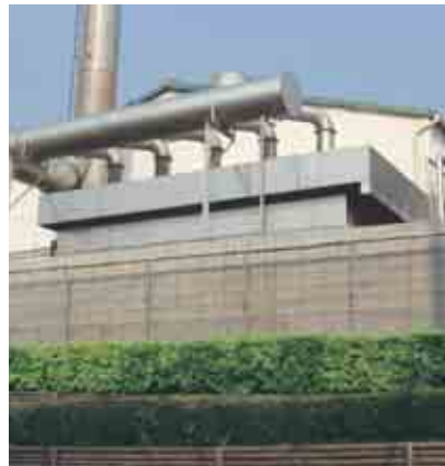
仙川工場貫流ボイラーと防音設備
