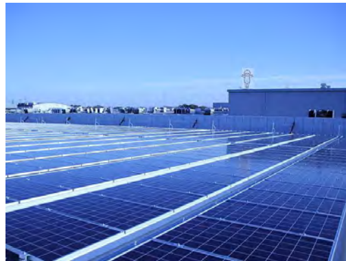
五霞工場に新設した太陽光発電設備
