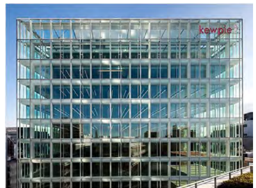
2重ガラスが覆う(ダブルスキン)外観
