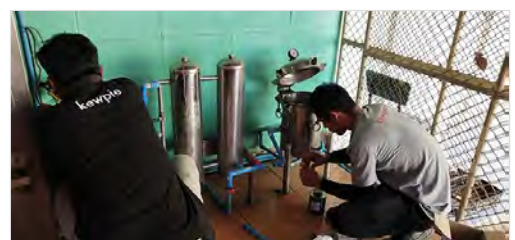
水道設備メンテナンスの様子
