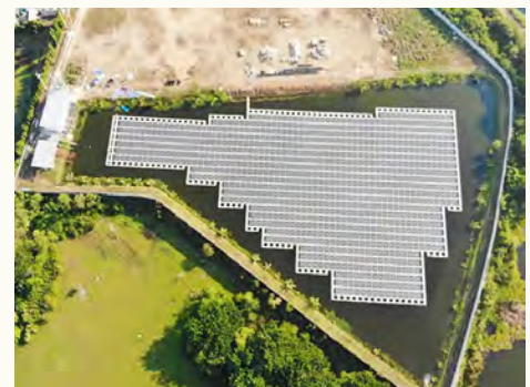
タイの生産事業所に設置した水上太陽光発電施設
