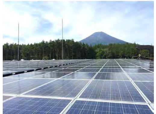
富士吉田キユーピーに設置した太陽光パネル
