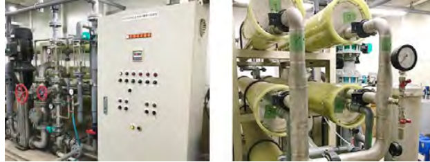
逆浸透膜(RO)ろ過装置
