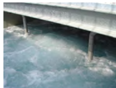
中空糸膜モジュール ユニット(散気中)
