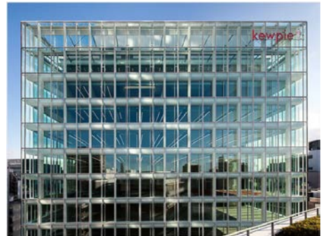
2重ガラスが覆う(ダブルスキン)外観
